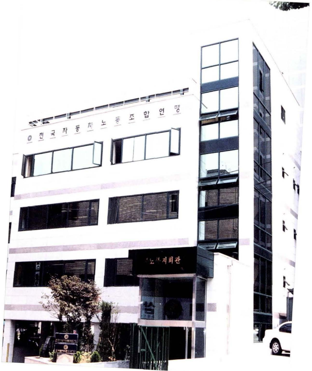
운수노동운동의 산실 - 전국자동차노련회관 전경
